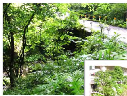
林道日影線橋
